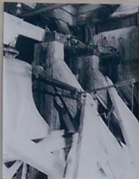
DIE GLOCKEN SOLLTEN WIEDER TÖNEN! WAS LÄNGE WAHRT, WIRD GUT! AUS LÄNGER PLANUNG REIFTE EIN SPONTANES ZIEL: GLOCKENGELÄUT ZUR HOCHZEIT AM 29. JULI 1989. ALLE KRÄFTE WURDEN MOBILISIERT. GLOCKENLAGERHERSTELLUNG, ÜBER NIMMT SCHWIEDEMEISTER WITZKE, ENTRESTUNG UND ANSTRICHARBEITEN DER STAHLGLOCKEN DURCH LAHNERKRÄFTE.
